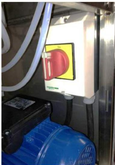
Ved et teknisk arbeid på enheten, er det i noen tilfeller nødvendig å koble fra strømmen. I tillegg til effektbryter som må monteres i nærheten av bekkenspyleren, er det en skillebryter i enheten.
